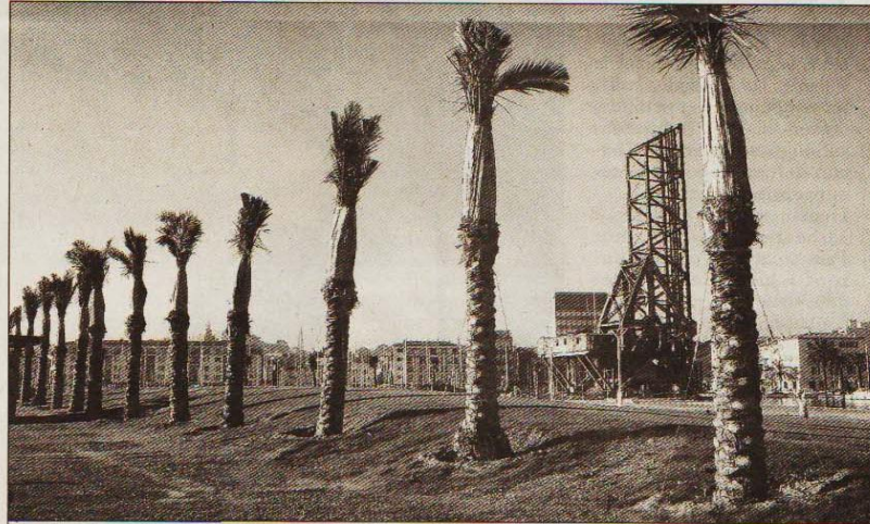
Telle une sentinelle veillant sur la ville, véritable trait d'union entre le passé et le présent, le pont levant est appelé à être rénové.
