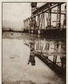
Ancien traceur aux chantiers, Michel Breil est aussi un photographe de talent
