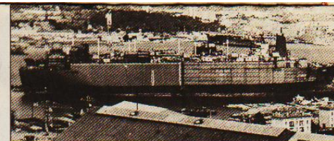
Le méthanier Larbi Ben M'Hidi (N° 1414) : L. de 266,20 m ; l. de 41,60 m ; vitesse aux essais de 19,4 nœuds et capacité de 130 000 m 3 . Construit entre 1974 et 1976.
